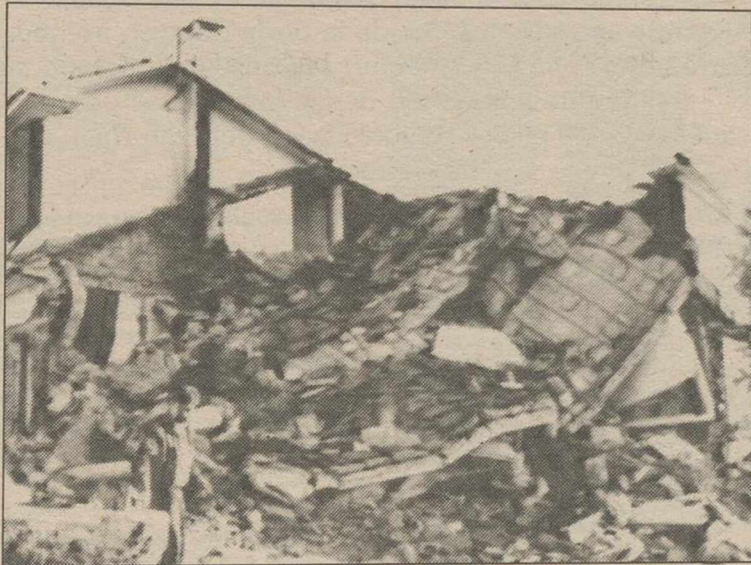
Estado en que quedó el chalet de Fraga.
