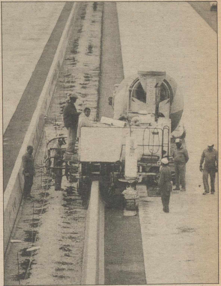
Las obras de la variante de La Roda se encuentran prácticamente concluidas.
