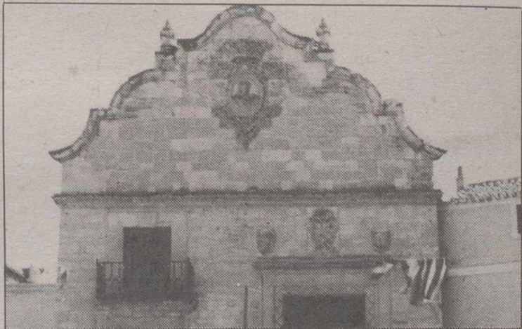
Fachada principal del Ayuntamiento.
