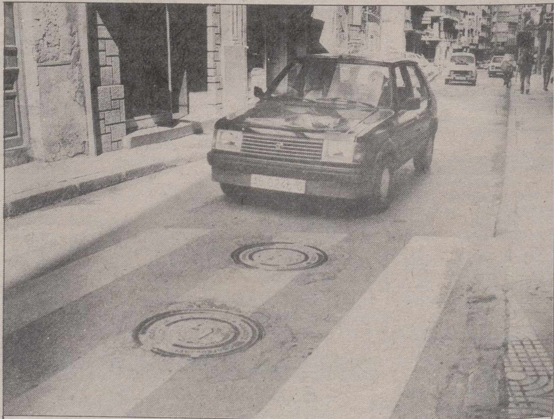
Una rueda de bicicleta para evitar los ruidos molestos. Esta ha sido la solución que Víctor, el pastelero de la calle del Rosario, ha dado para evitar el ruido tan molesto que producía la chapa de la alcantarilla levantada sobre la calzada. La solución sigue sin resolver el problema de hundimiento con que se ve amenazado el paso de vehículos.
