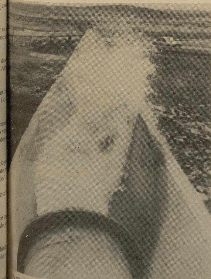
A más de trescientos litros por segundo asciende el caudal de agua de un pozo perforado en la zona conocida como "Las Cortesías", situada a un kilómetro aproximadamente de El Salobral. Las obras de prospec-
