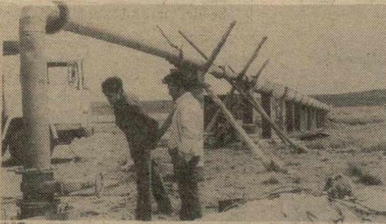
El pozo tiene una profundidad de 180 metros en columna y su nivel apenas ha bajado después de veinticuatro horas de aforo.
