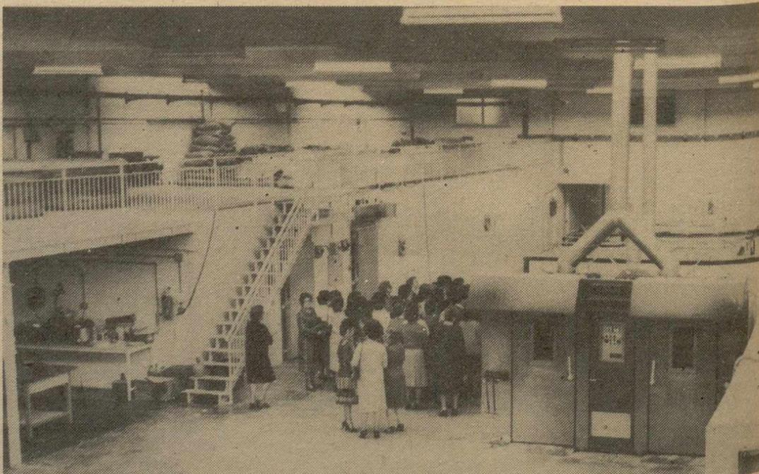
que el pan para nada: en primer lugar, la harina, agua y levadura, se introducen en las amasadoras, después de hacerse la masa, ésta pasa a una pesadora que saca las bolas de masa con el peso preciso, a continuación pasa a la harinadora y de ésta a la cámara de reposo para que la masa tome cuerpo, después la máquina formada de barras, con un espectacular movimiento va distribuyendo la masa en forma ya de barra en 26 departamentos, que van a la cámara de fermentación y tras pasar por unas
