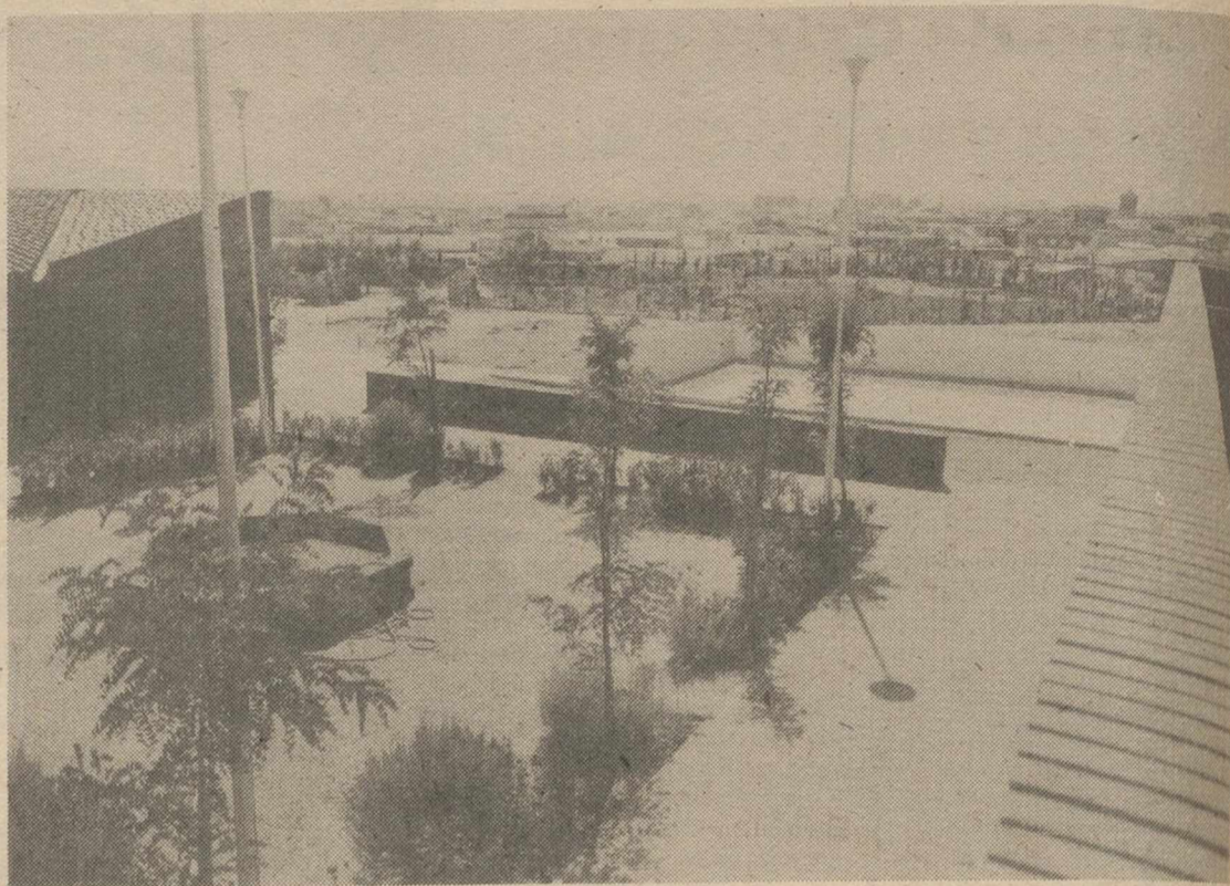
Villarrobledo tiene abiertas las posibilidades a la expansión y el ocio de sus gentes en sus magníficas instalaciones de Polideportivo. Ha sido una obra bien hecha, con proyección social, a tono con el crecimiento de una ciudad que ofrece alicientes de todo tipo. El verano, en Villarrobledo, tiene encantos para propios y extraños. Como debe ser en una ciudad moderna
