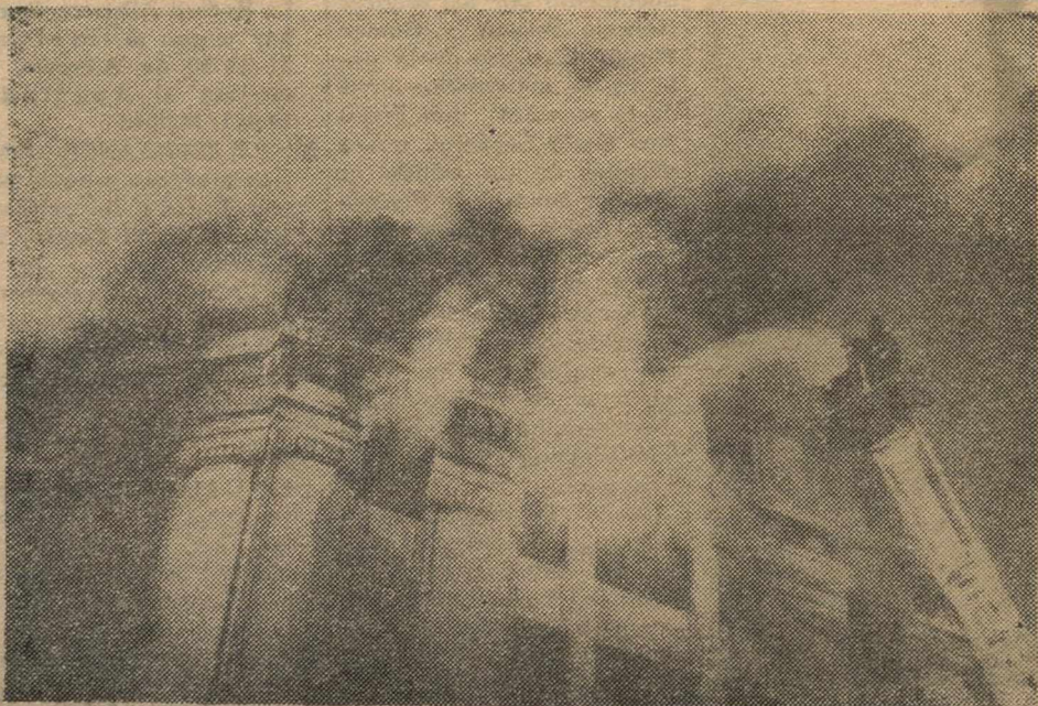
BARCELONA.—En la noche del viernes se declaró un gran incendio en el edificio de la Telefónica de la Ciudad Condal, sito en la Plaza de Cataluña, causando grandes daños en el mismo y en las instalaciones de líneas telefónicas.—(Foto EUROPA PRESS)
