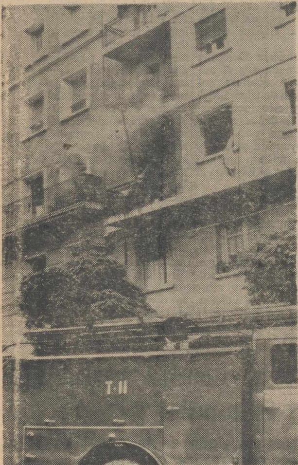
En la foto, una vista del edificio del Consulado, inmediatamente después de haber hecho explosión el artefacto incendiario.—(Telefoto CIFRA GRAFICA)
