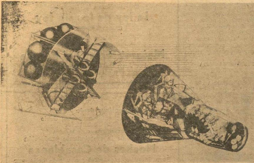
La cápsula espacial "Géminis-4" en cuyo interior van los astronautas Mcdivitt y White está compuesta por tres secciones. La de la derecha (foto) contiene a los hombres, aparatos de experimentación y protección contra el calor. A la izquierda, juntas, hay dos secciones, la retrógrada que lleva cuatro cohetes de frenaje, y la de equipo que porta las baterías eléctricas, oxígeno y combustible para los pequeños cohetes de maniobras.—(FOTO FIEL).
