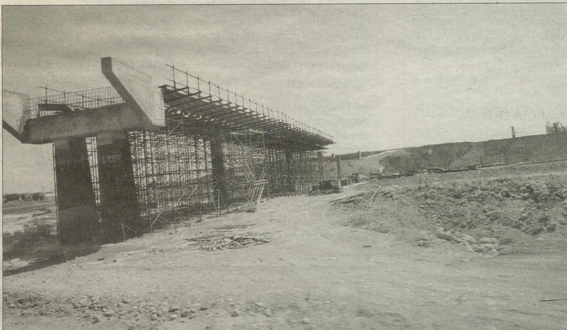
La infraestructura que conecta Extremadura con Valencia, a su paso por Ciudad Real, se lleva la mayor inversión de los PGE.
