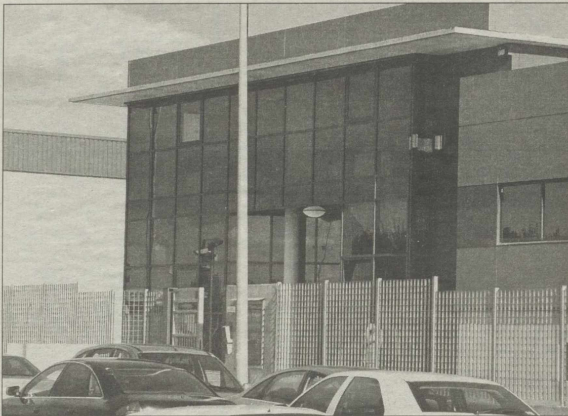
Fachada del CEEI de Ciudad Real
