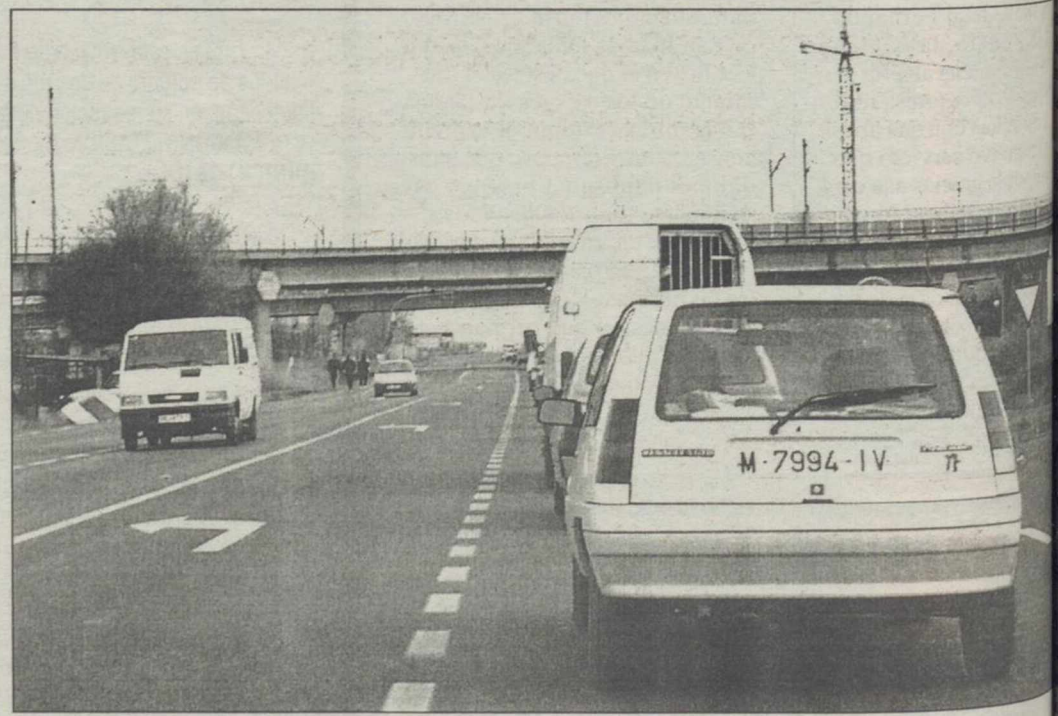
Las obras supondrán una inversión de casi 7.000 euros
