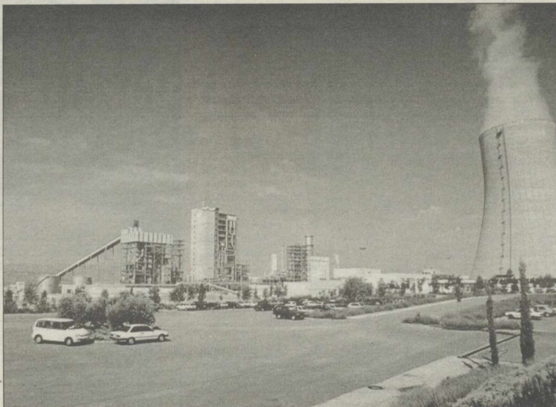
Vista general de la planta de la empresa Elcogás
