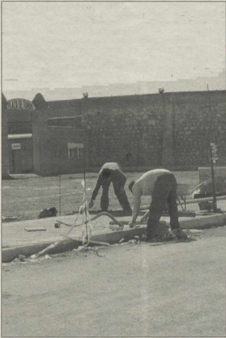
Obras en el paseo del albero
