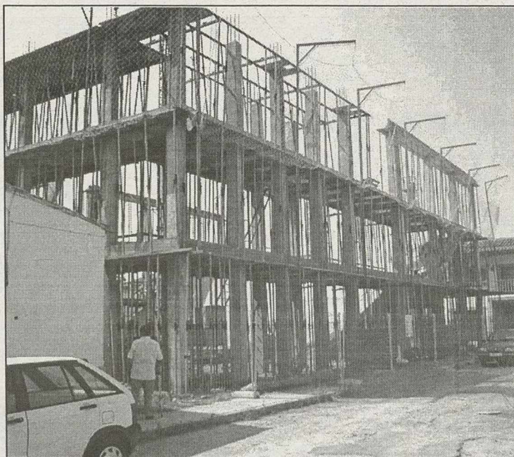
Obras del teatro municipal de la localidad de Moral de Calatrava
