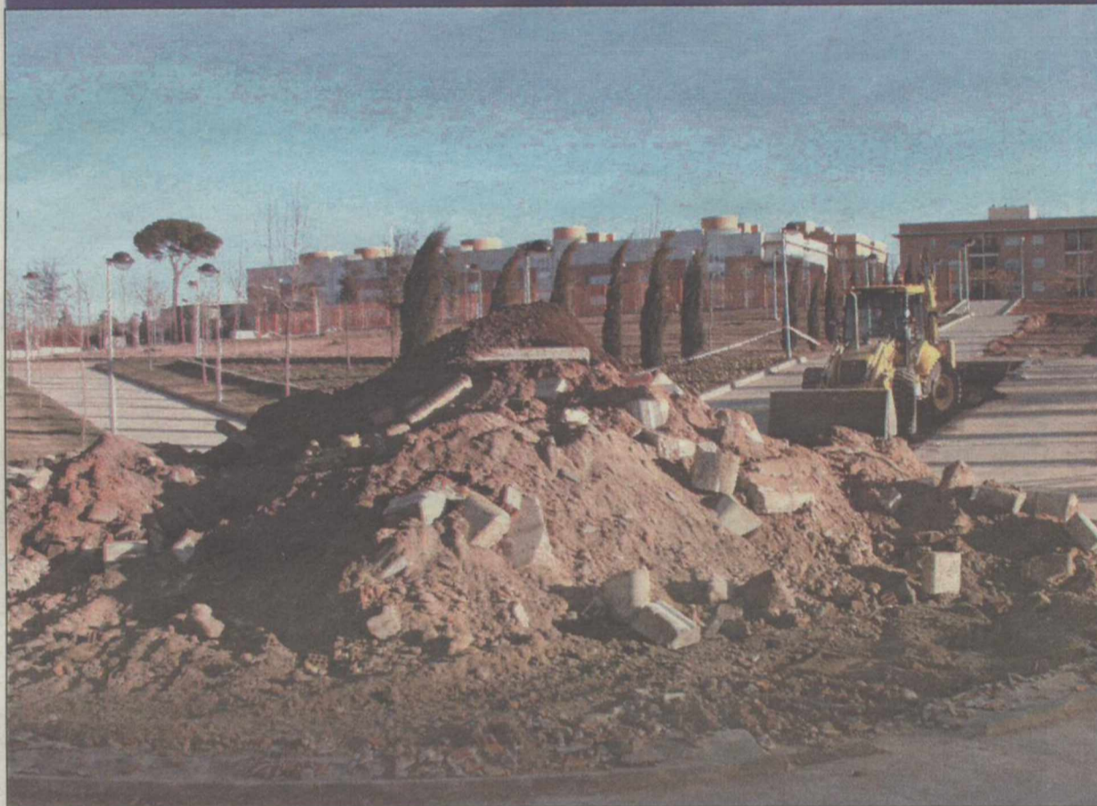
Comenzó la construcción de una fuente en el Gasset
