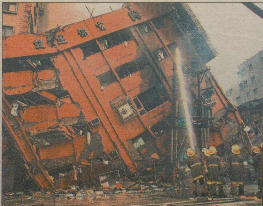
Uno de los edificios derribados en Taipei.
