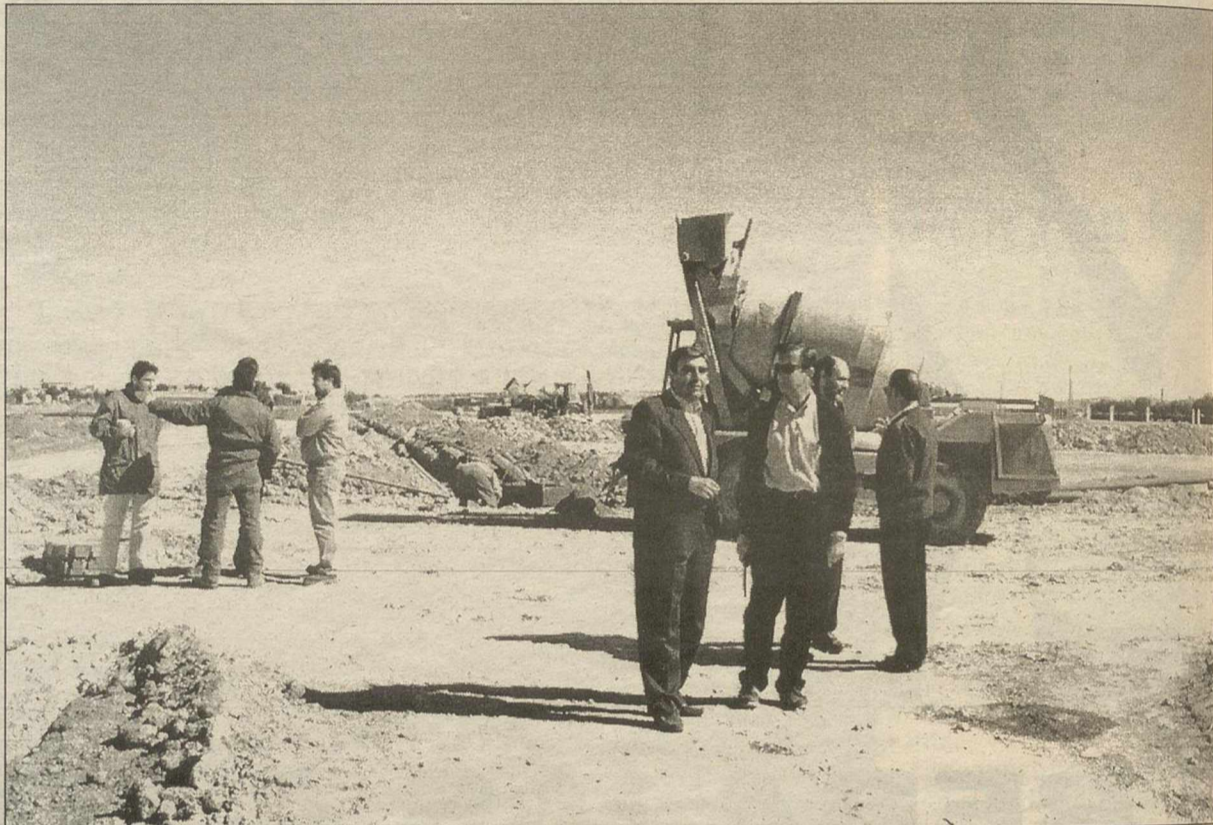
El alcalde de Bolaños, Almansa examinando las obras del polígono.
