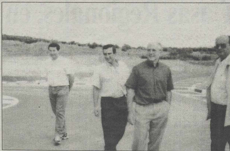
Fernández-Pacheco supervisó la terminación de las obras.
