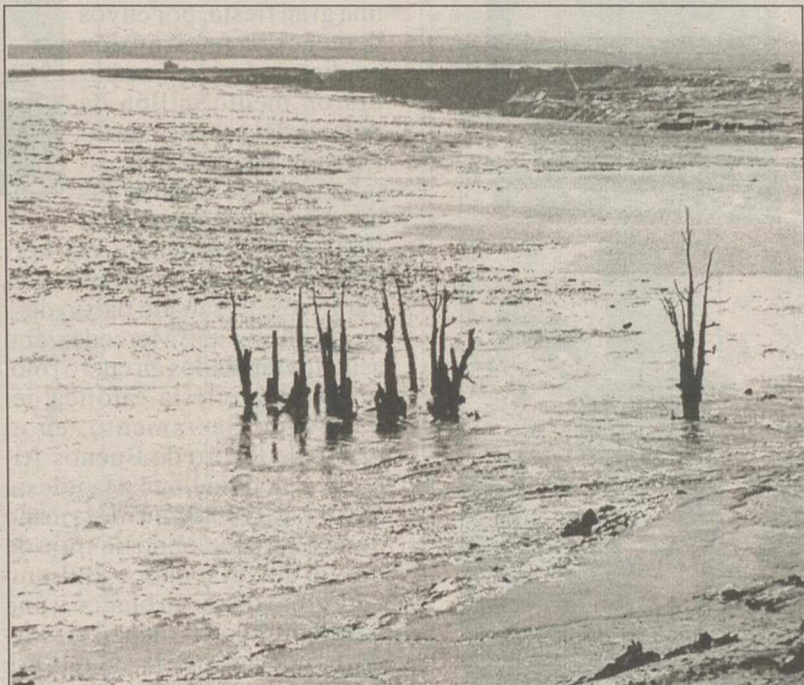
Miembros del Gobierno andaluz visitarán las obras de la balsa.
