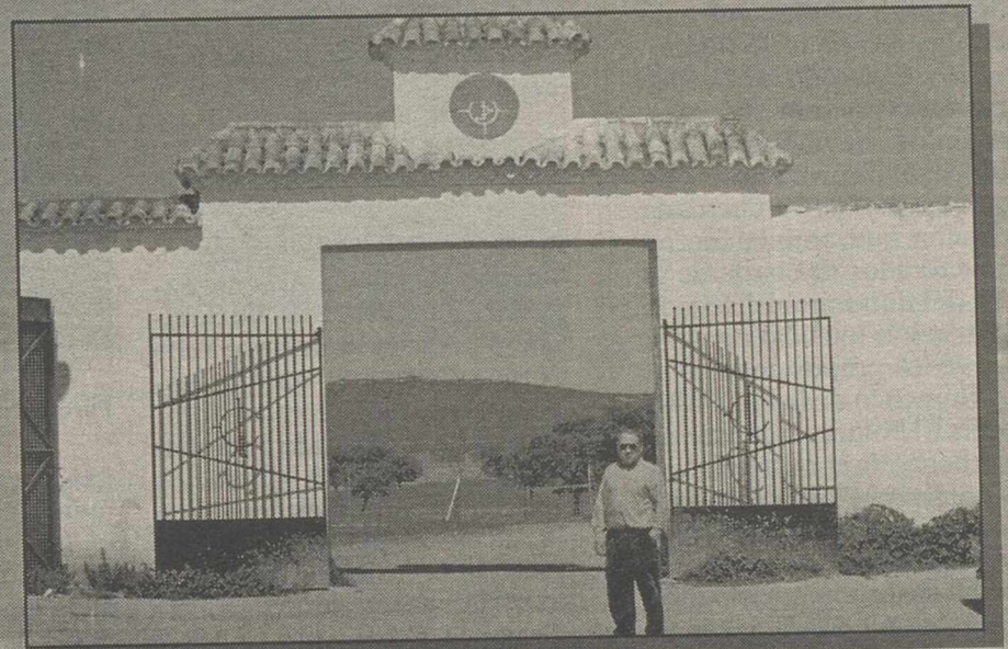
Entrada a la Finca "El Consuelo" de Villamayor
