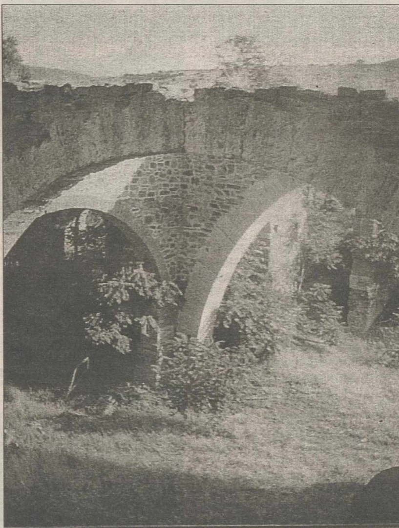
Los vecinos de Los Pozuelos reclaman la construcción de Los Reznos.
