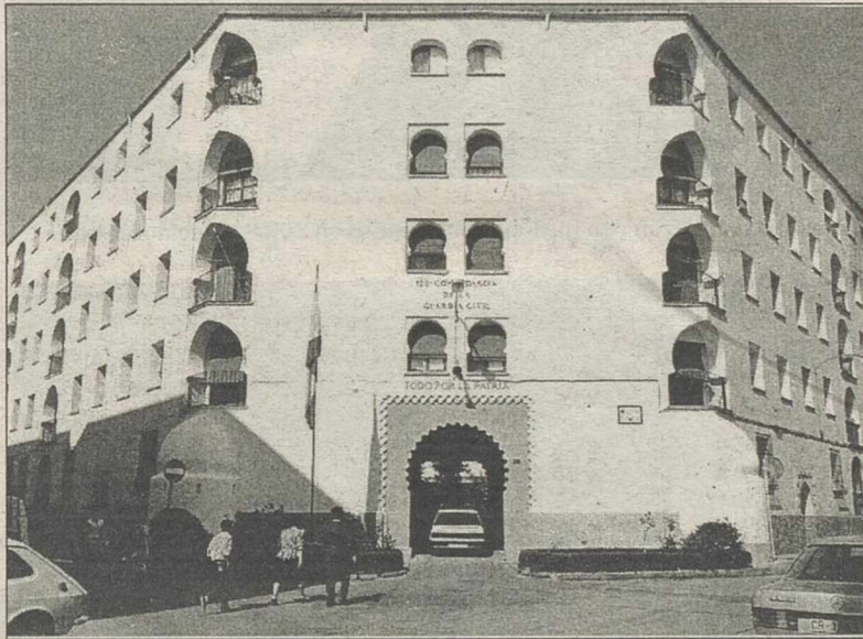
El edificio de la Comandancia se ha quedado obsoleto.
