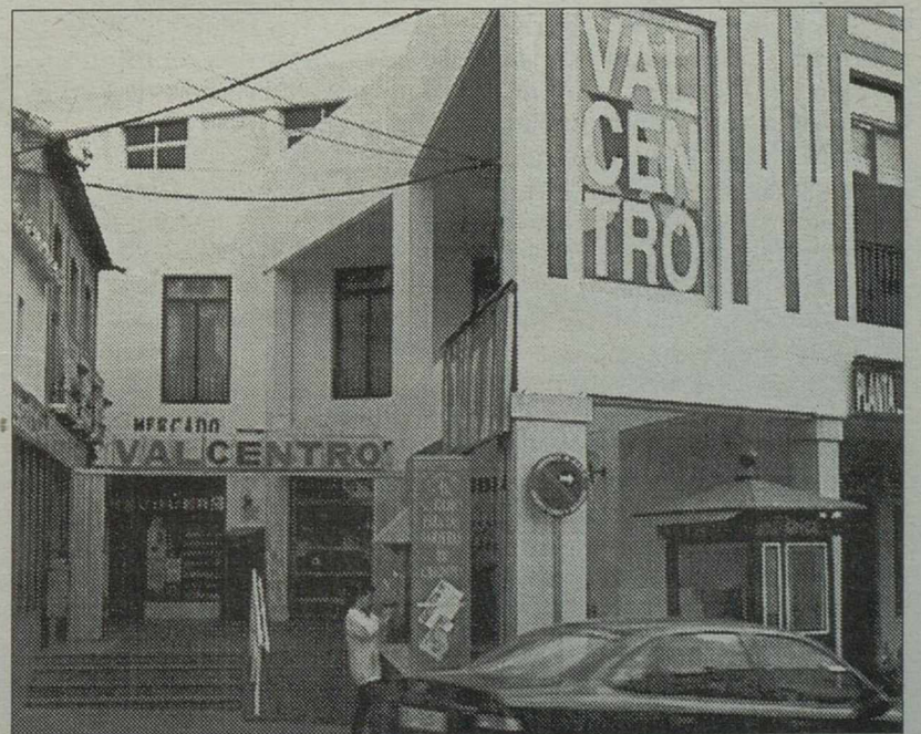
Edificio de Valcentro, donde está ubicada la sede de MANSERJA.
