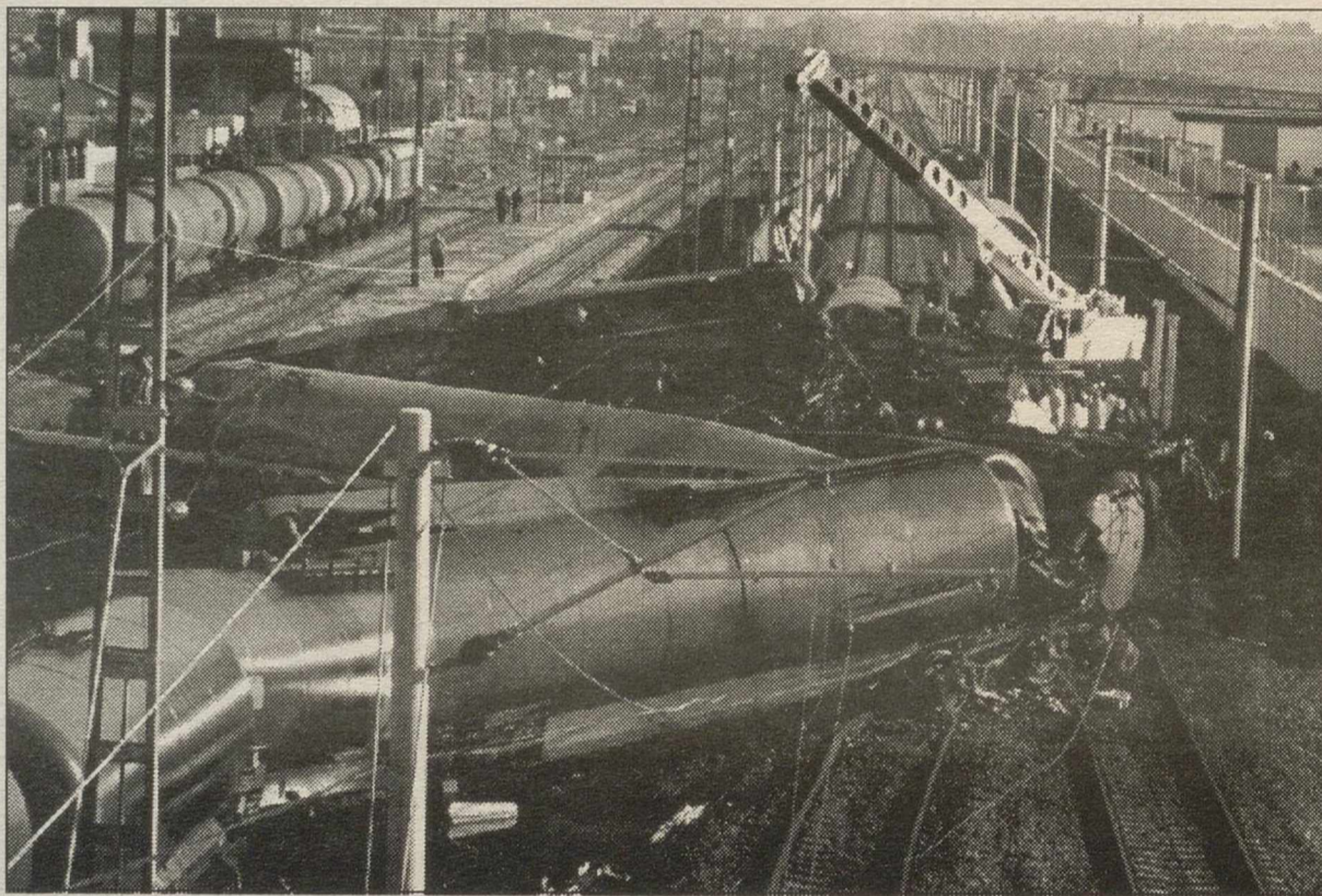
Los vagones volcados en la vía de AVE fueron retirados con la ayuda de una grúa.
