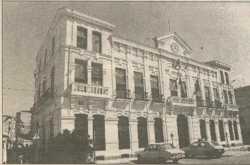
El Ayuntamiento cuenta con 80 millones para las obras del centro de primaria.
