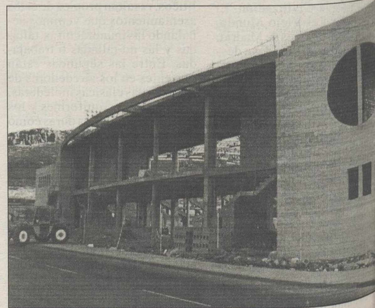
Ya falta menos para el final de las obras.
