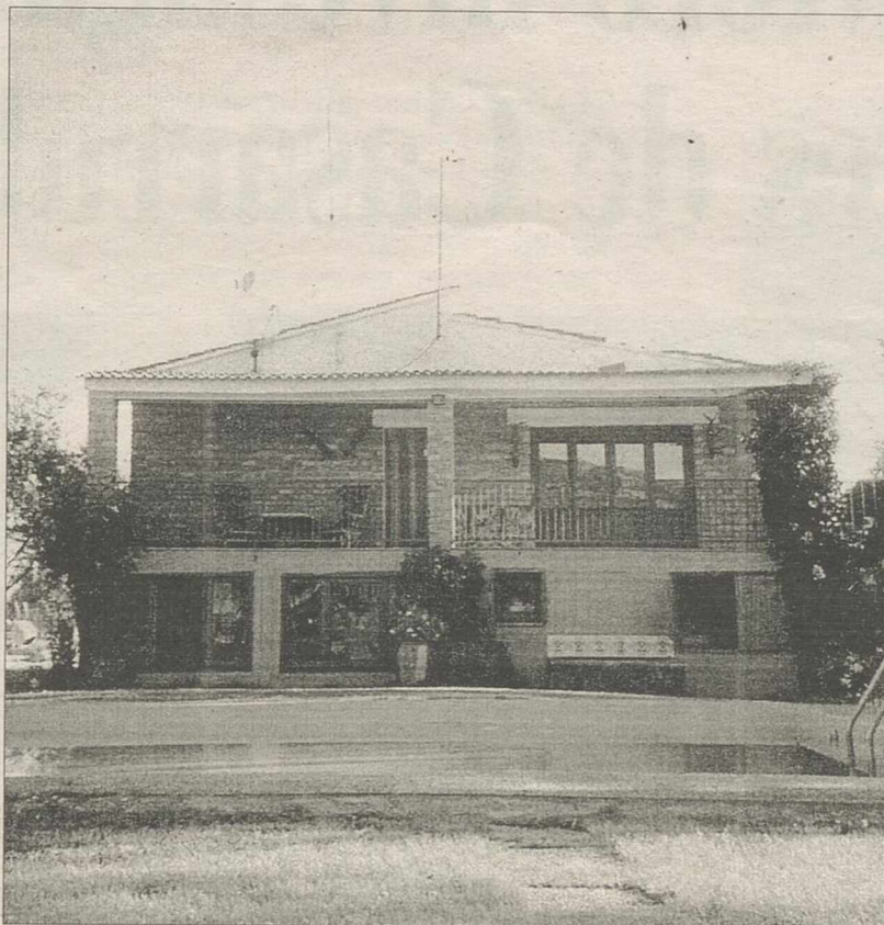
Vista de la casa rural "Los Galápagos"
