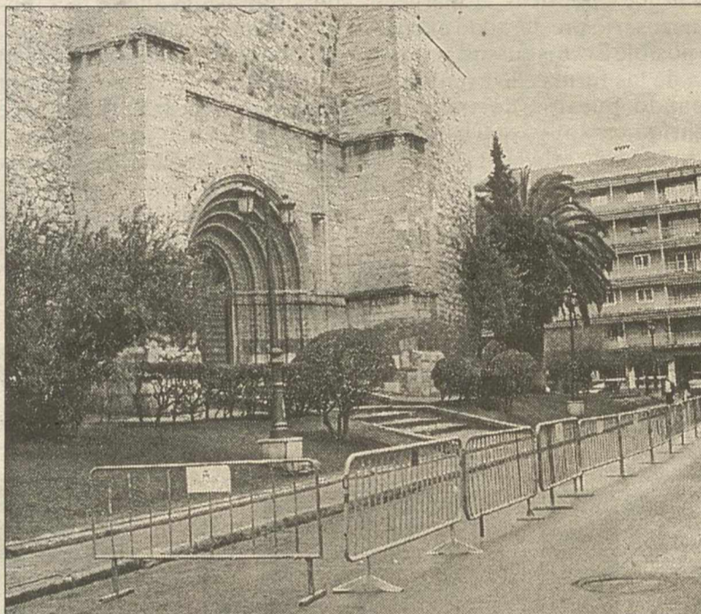
Las obras comenzaron ayer vallando la zona.
