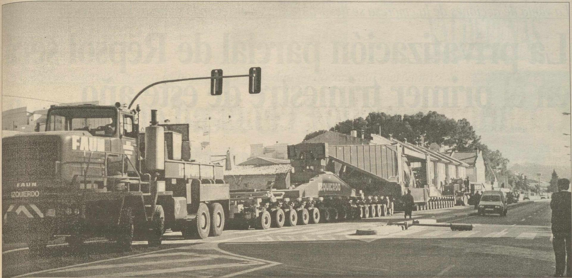
El convoy está formado por un vehículo tractor, un remolque de 28 ejes, y otro vehículo similar en la parte trasera, que empuja al transporte.
