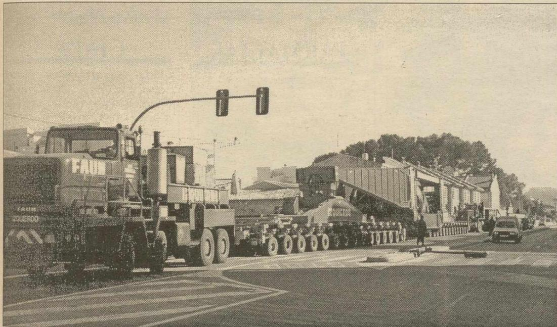
A simple vista es un monstruo de acero, gigante y de paso lento, pero se trata de la turbina que Elcogás instalará en la central de Puertollano. Este convoy, que ronda las 500 toneladas, se arrastra pesadamente sobre 242 ruedas a una velocidad de tres o cuatro kilómetros por día. El camión que la conduce se encontraba ayer en las proximidades de Bonete, en la provincia de Albacete.
