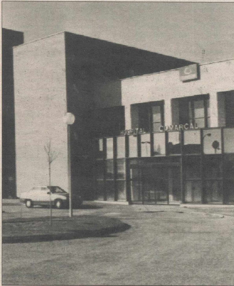
Los responsables de UGT y CCOO denuncian deficiencias en la construcción del hospital
