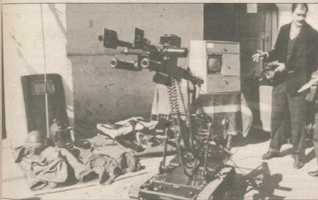
► **Sofisticado material para desactivar explosivos.** La Comandancia de Ciudad Real acaba de recibir un importante equipo de desactivación de explosivos, llamado "GEDEX", con el robot "whell-barrow MK-7", capaz de desplazarse hasta cien metros y manipular cualquier paquete que resulte sospechoso.
