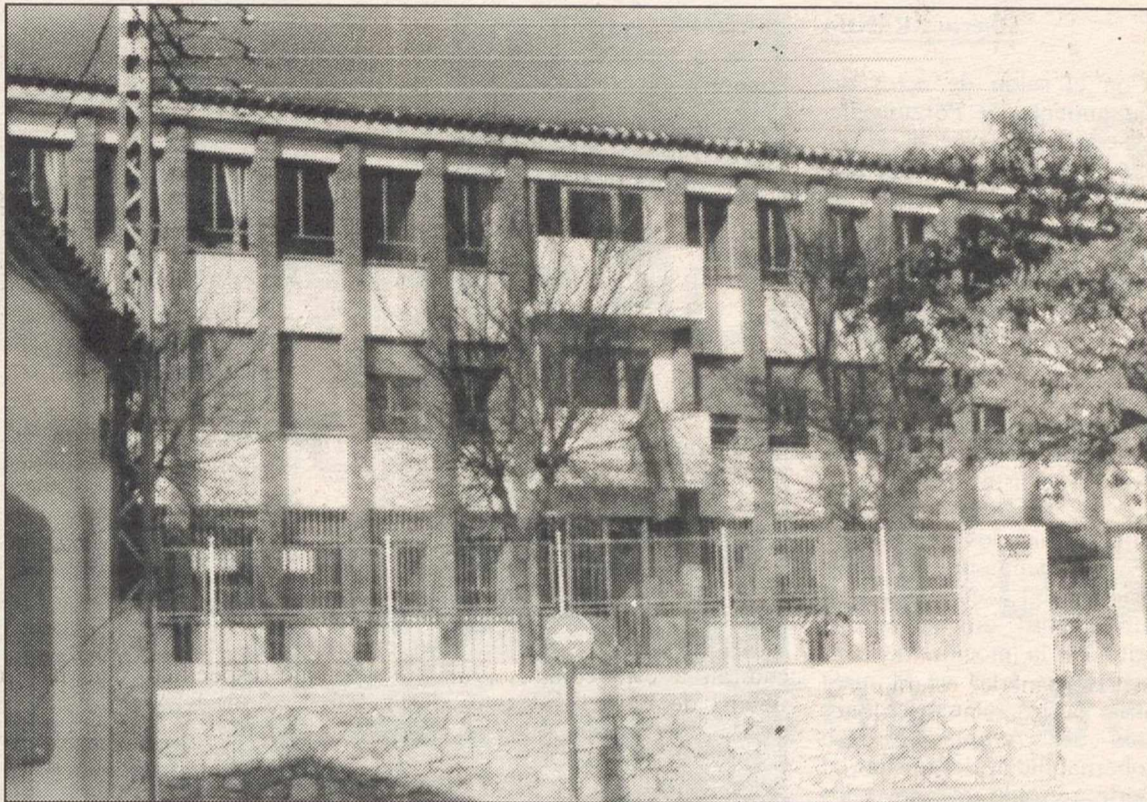
El colegio El Santo contará con nuevas aulas, cuyas obras finalizaron hace dos meses
