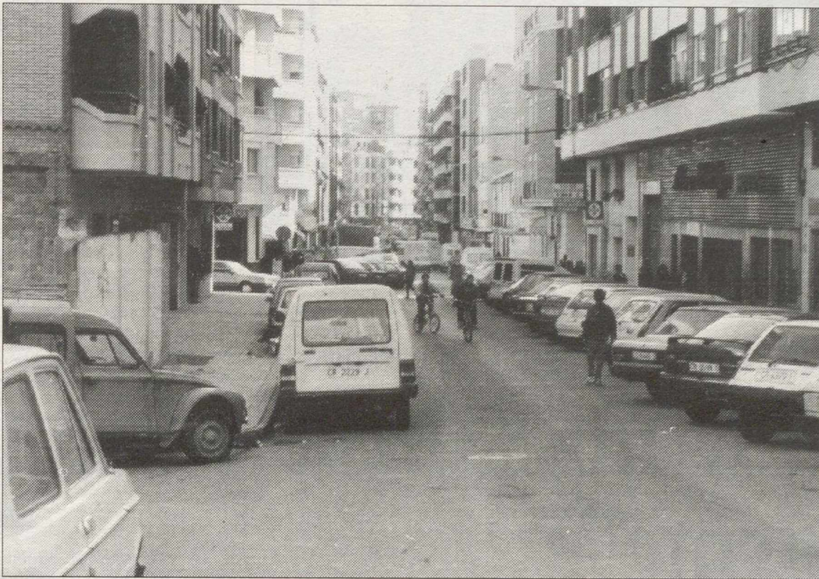
El inicio de las obras de la reordenación de tráfico comenzará la próxima semana
