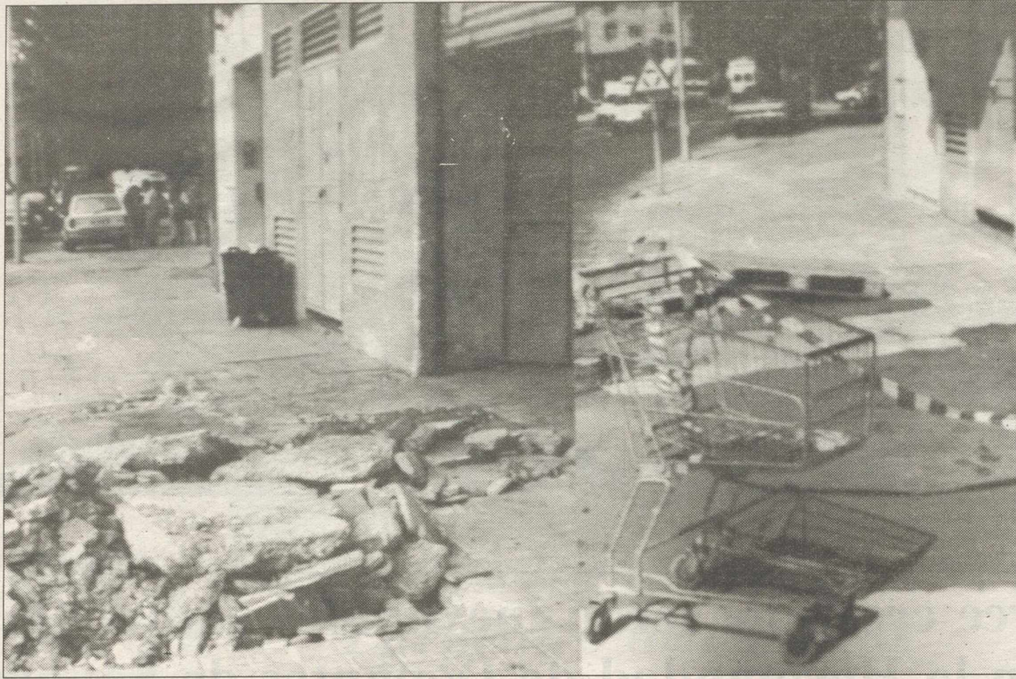
A la izquierda, estado de las obras el lunes; a la derecha, el arreglo realizado ayer
