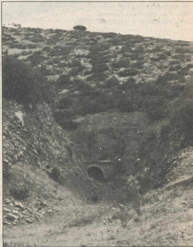
Salida del primer túnel, en el lado sur.
