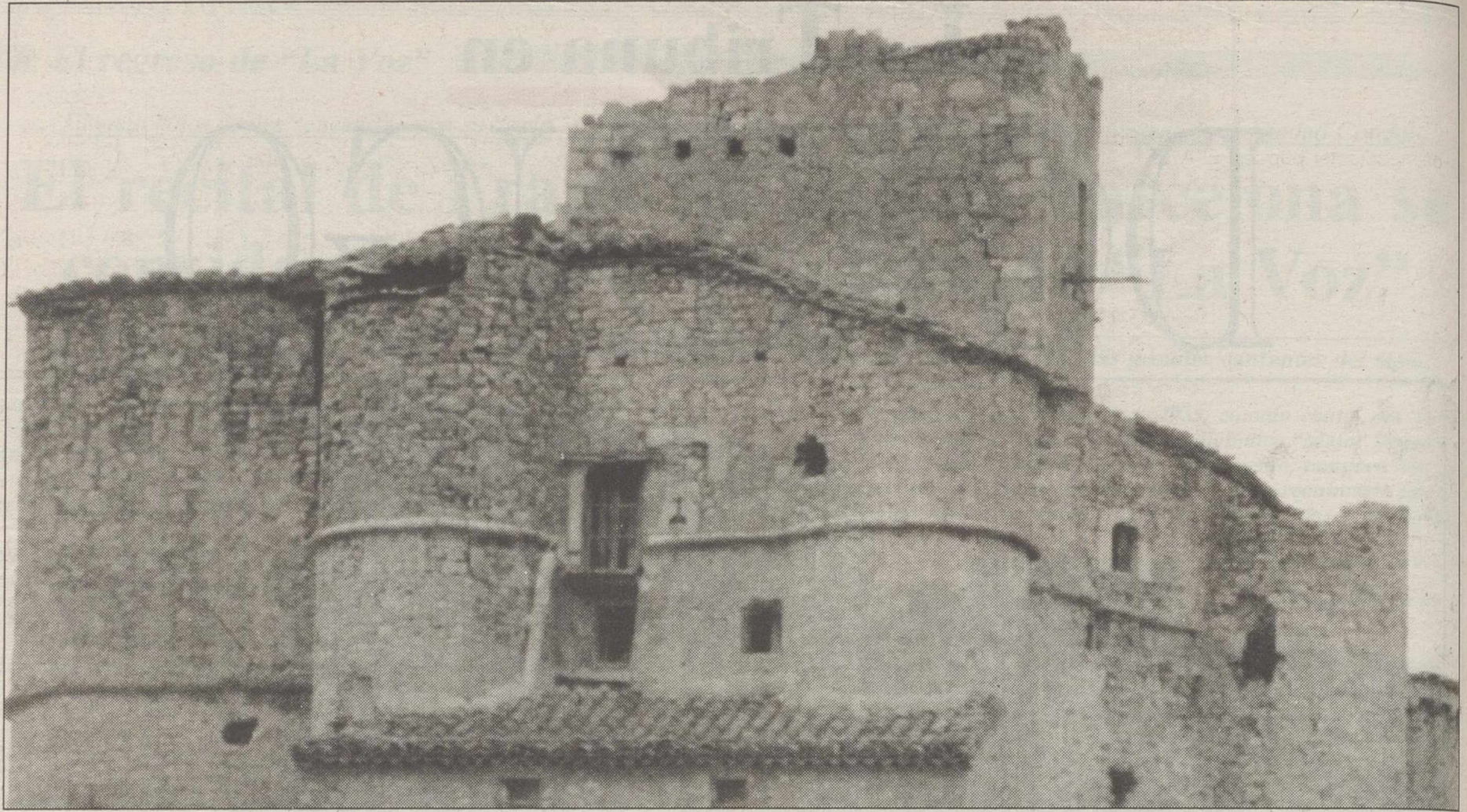
Fortificación medieval del caserío de Torrefuerte de la localidad de Salvacañete.
