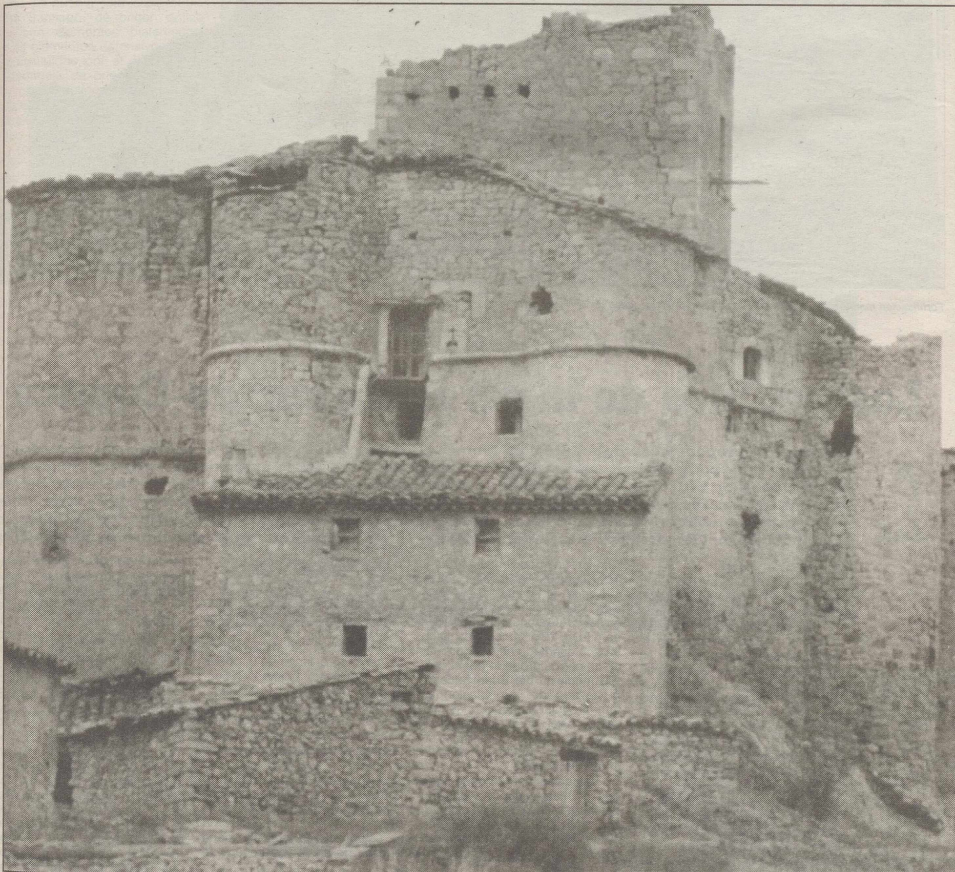
Fortificación medieval del caserío de Torrefuerte, de la localidad de Salvacañete.
