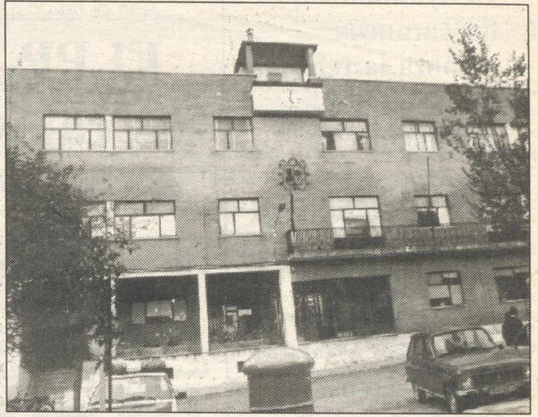
Ayuntamiento de Socuéllamos.
