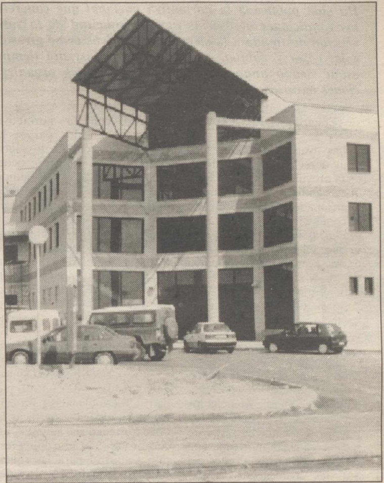
La nueva estación cuenta ya con todos los detalles que faltaban en la inauguración
