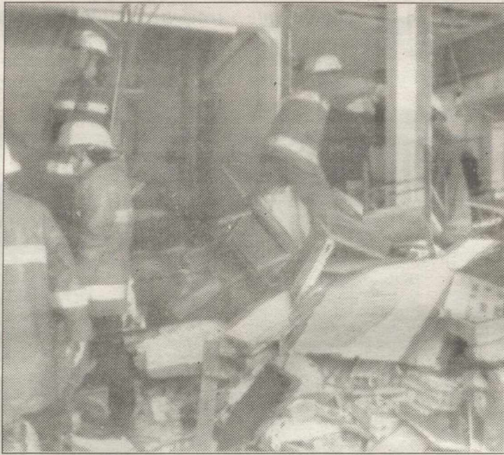
Una persona murió en el derrumbe.
