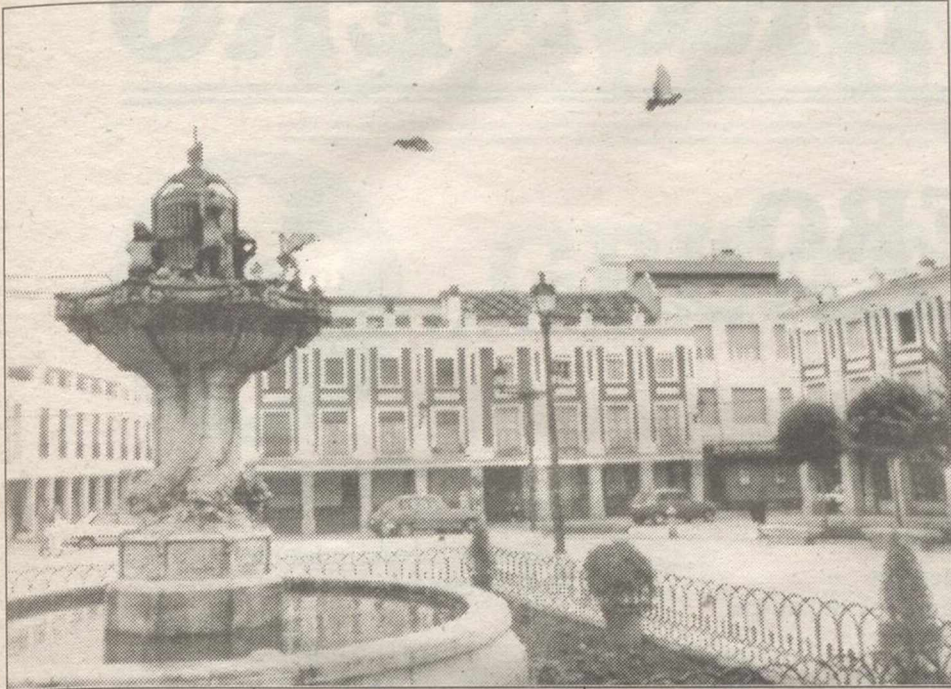
Los alumnos de la escuela-taller han ejecutado diversas obras en Valdepeñas.
