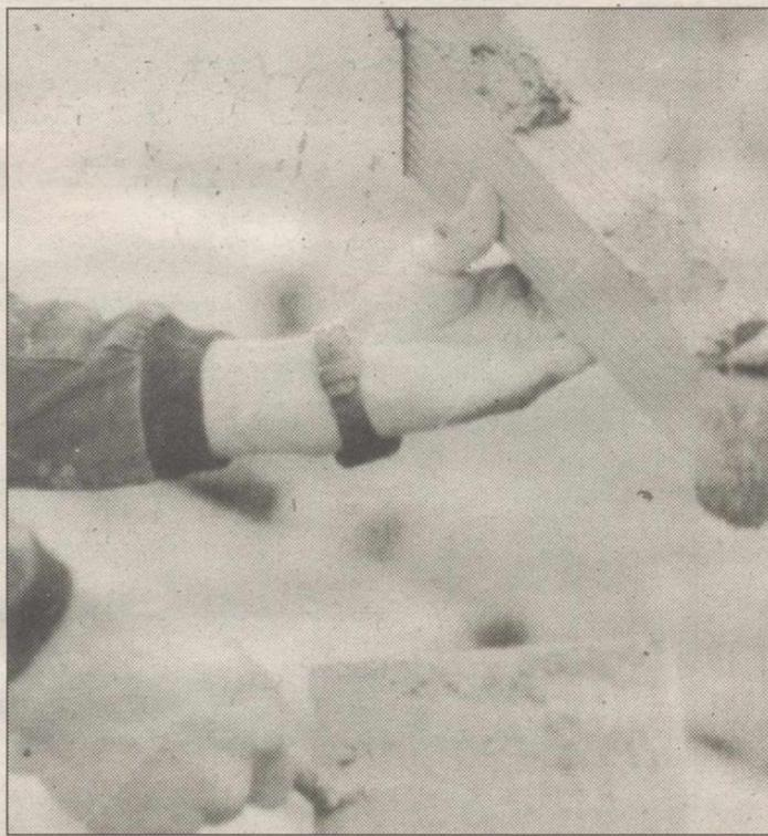
esto está en la instalación de una película transparente aislante y protectora en los cristales, de tan sencilla aplicación como una pegatina. Mediante esta finas capas de películas puede reducirse el impacto del calor en hasta un 19%.
