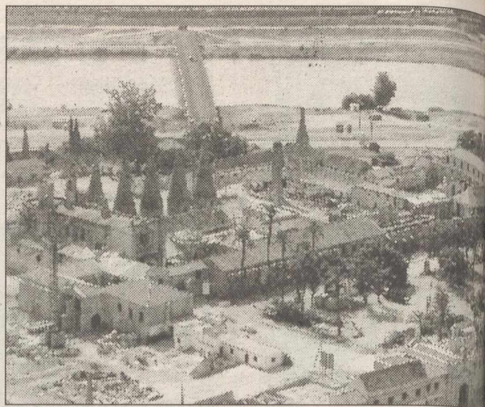
Las obras de Exposición Universal de Sevilla podrían paralizarse.
