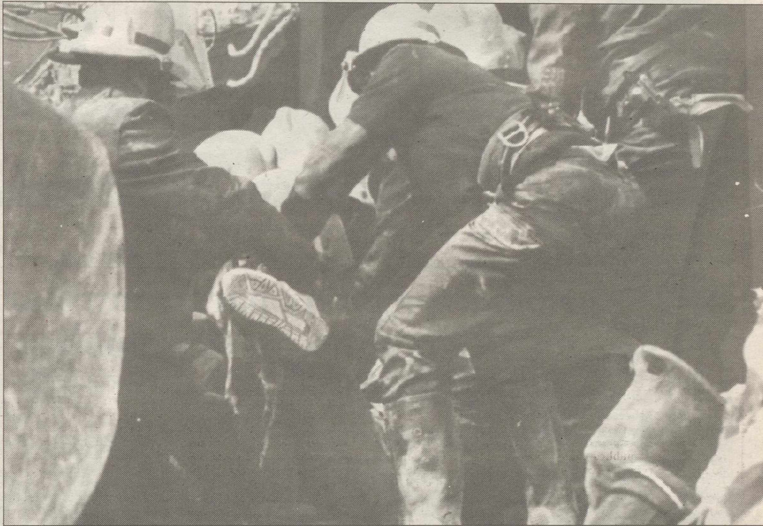
Los bomberos proceden al rescate del cuerpo sin vida de uno de los trabajadores sepultados en el derrumbe del hotel santanderino.
