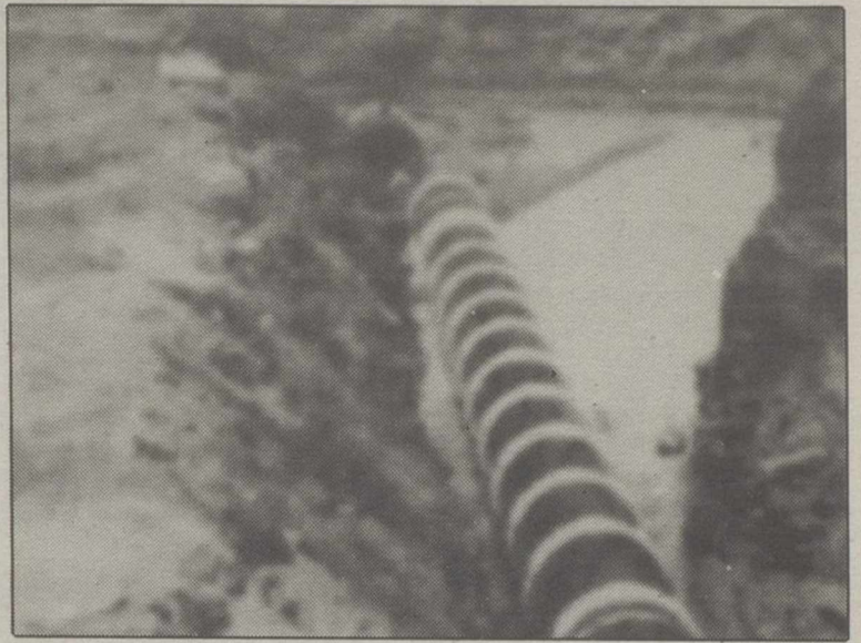
Obras del gasoducto en la provincia.
