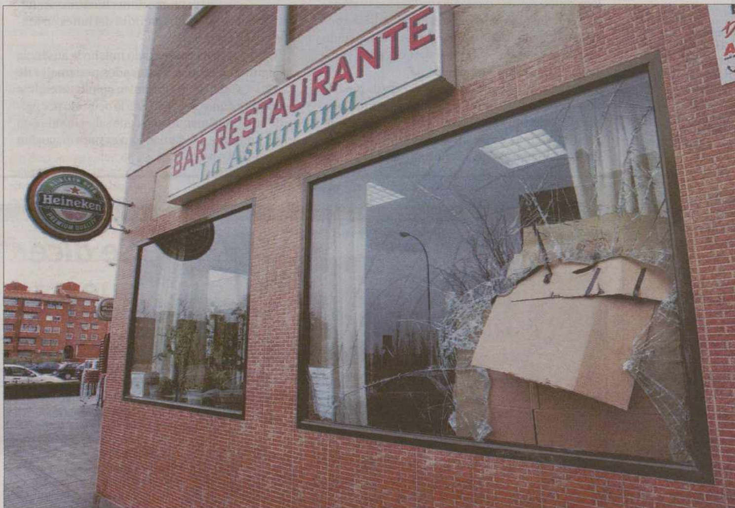
Los autores de los robos acceden a los establecimientos golpeando las lunas con una tapa de alcantarilla. / DAVID PÉREZ
