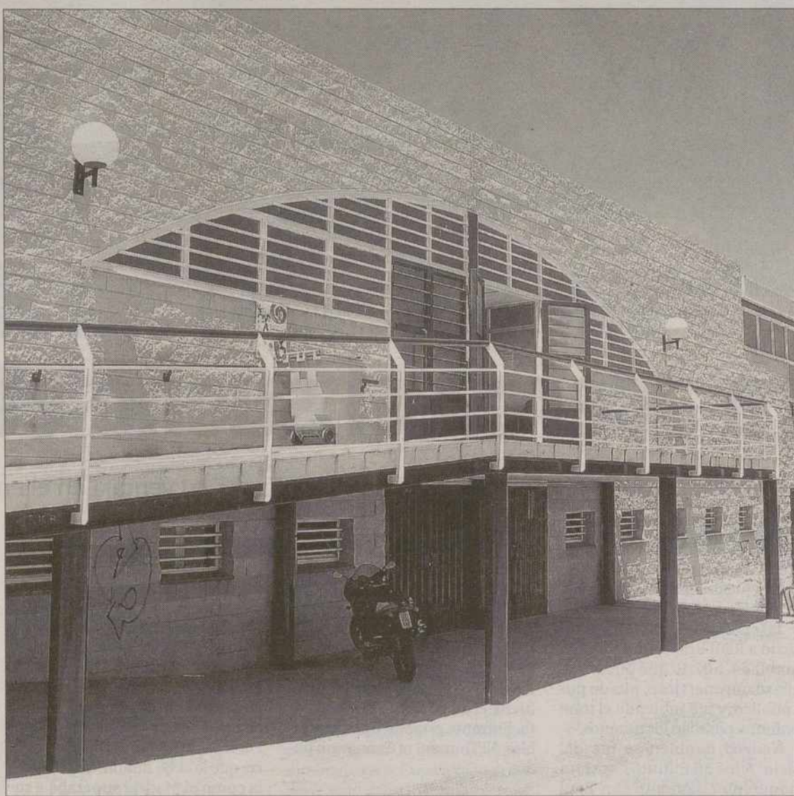
Las obras de acondicionamiento del 'Cristo de las Alas' concluyeron a comienzos del año. / YOLANDA REDONDO
