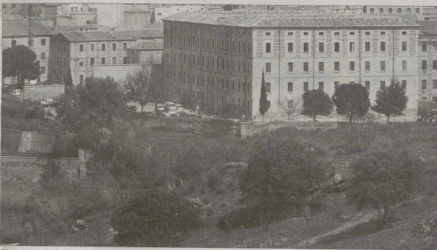
El lunes habrá una aclaración sobre los detalles que deben permitir que se construya el aparcamiento del Seminario. / VALDIVIELSO
