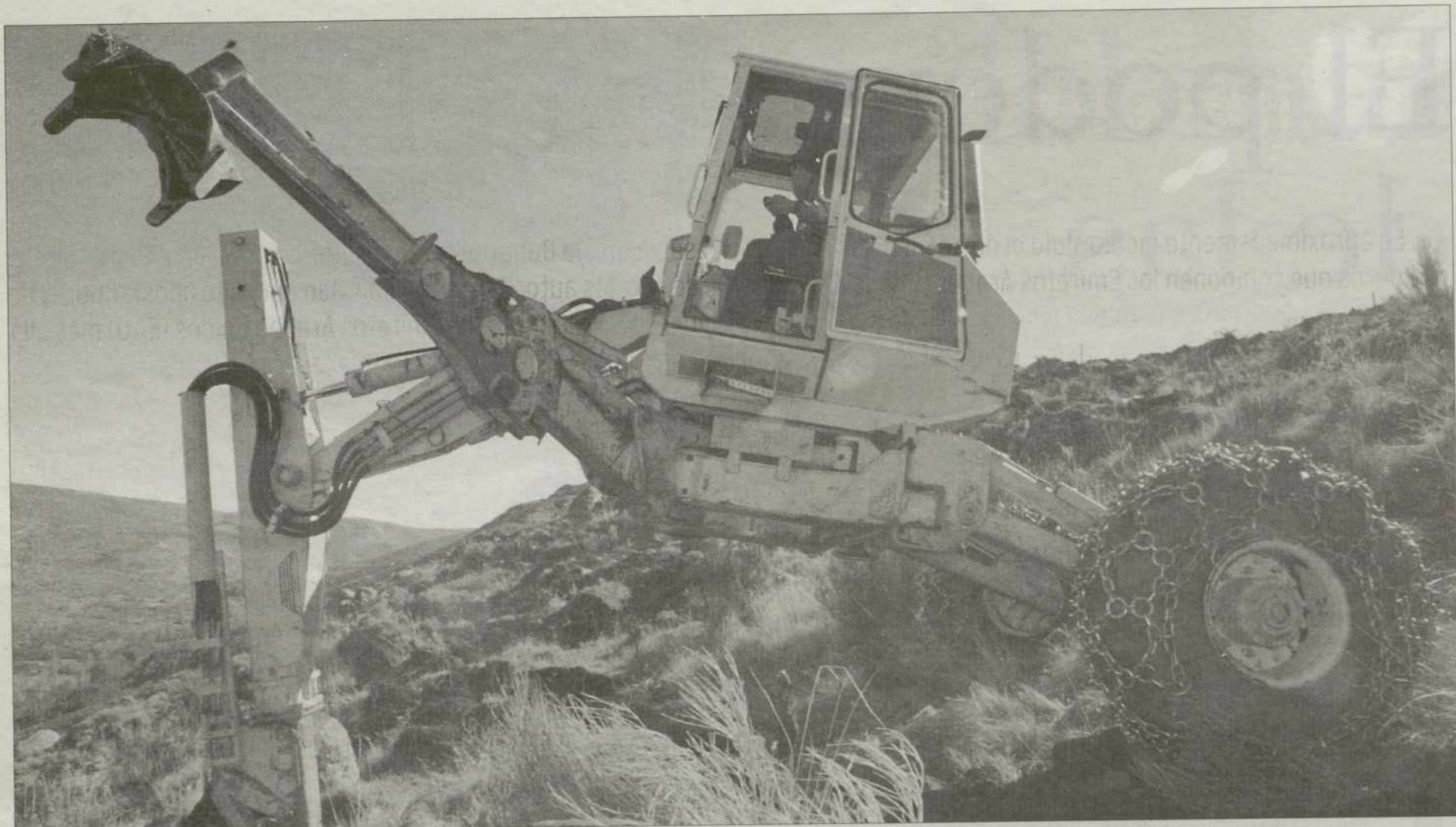
Una retroaraña que trabaja en la sierra de Gredos, en una zona con grandes desniveles.
