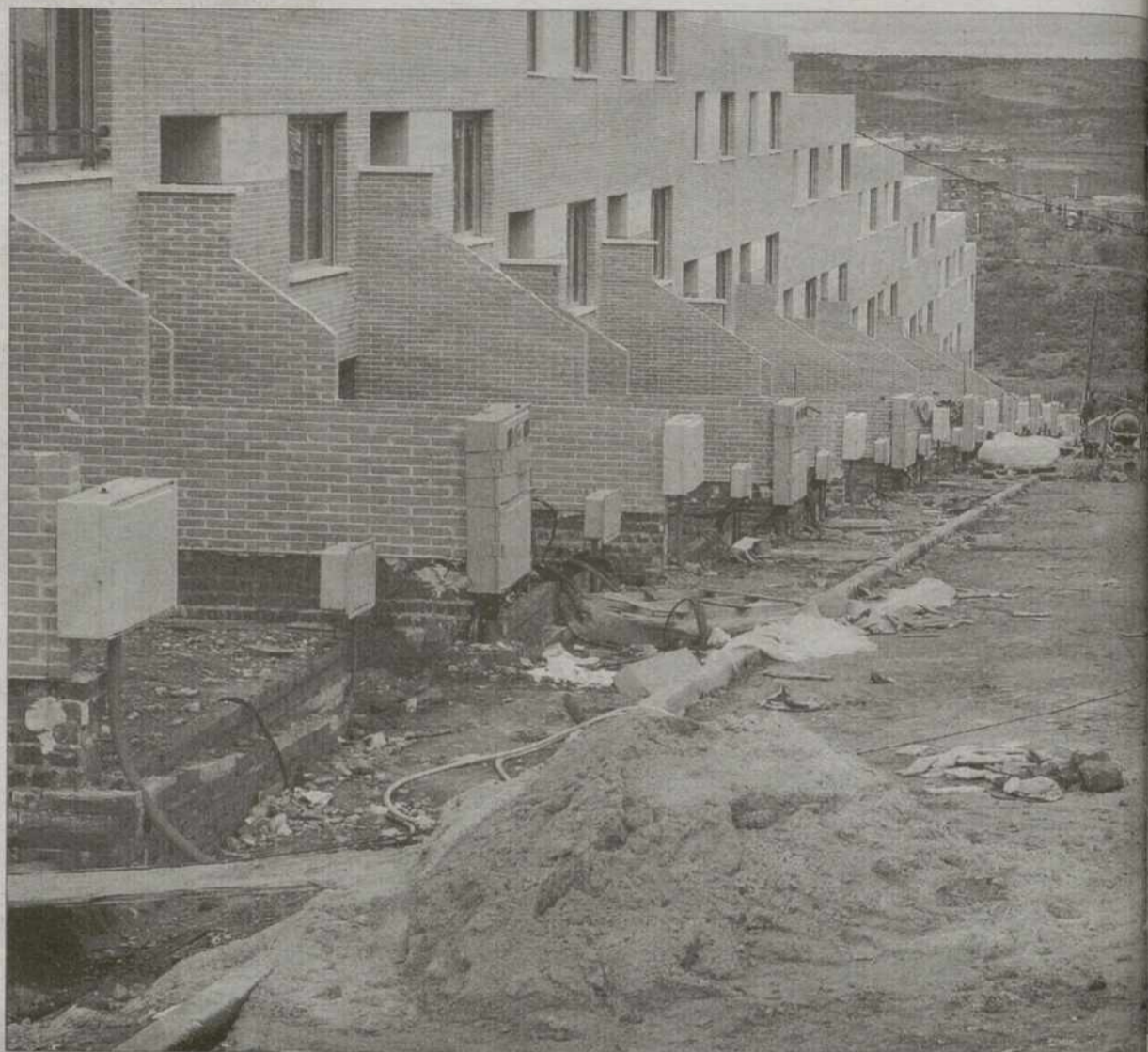
De nuevo 'Vitra' construirá en el sector 3 del Polígono. / DAVID PÉREZ
