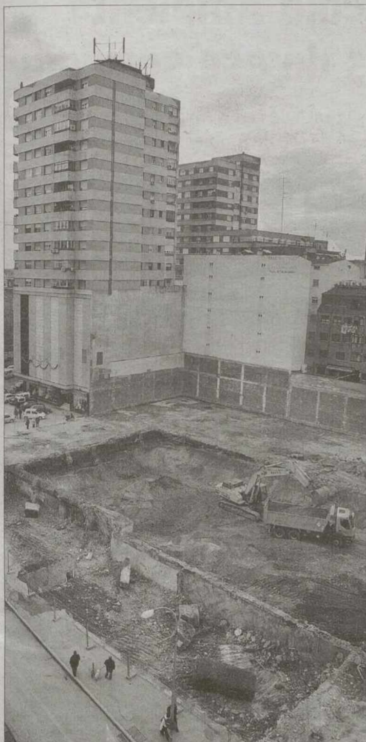
Las excavaciones del solar comenzaron la pasada semana. / MANU REINO
