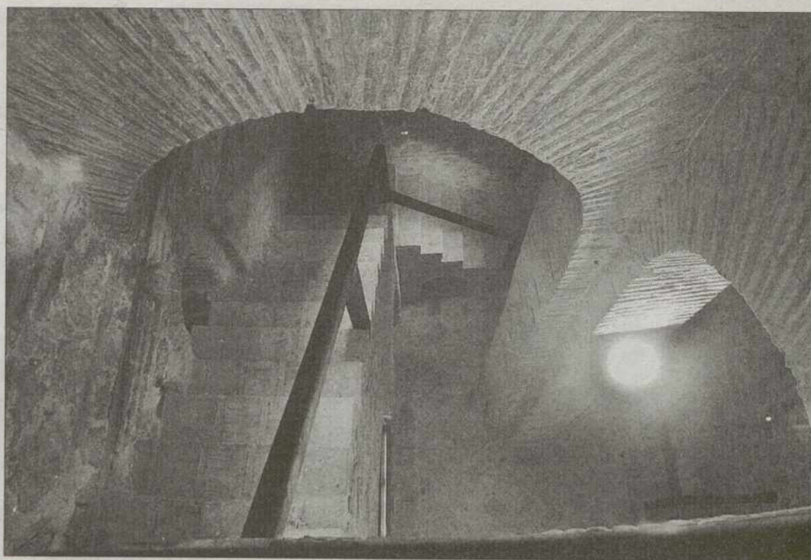
La Torre consta de cuatro niveles que culminan en un chapitel. /YOLANDA LANCHA
