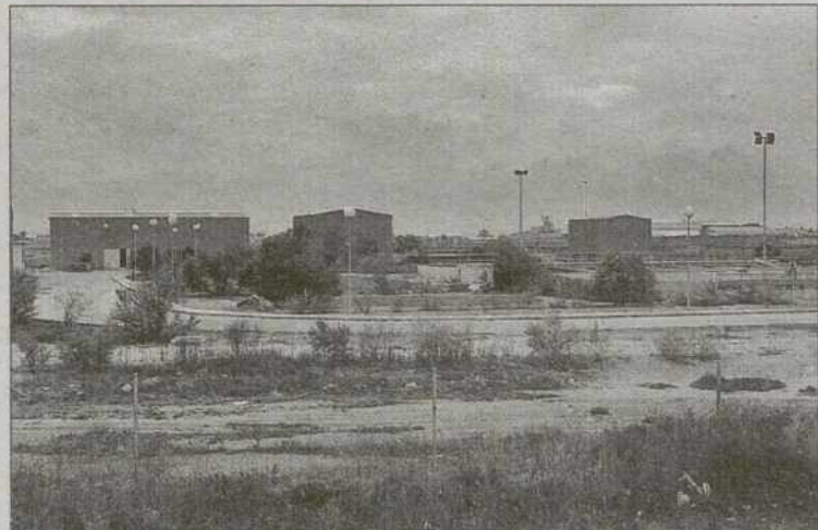
Esta es la depuradora actual que trata perfectamente las aguas. / DAVID PÉREZ
