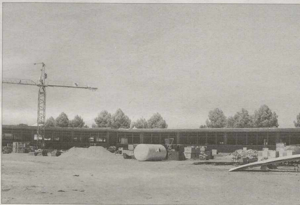
Desde septiembre, mes al que corresponde la imagen, las obras han avanzado sustancialmente. /C.S.
