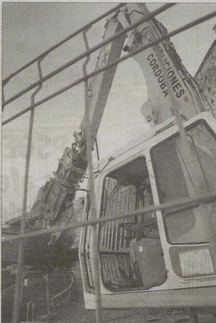
Trabajador de la constructora Necso en las obras del Miradero. / VALDIVIELSO
